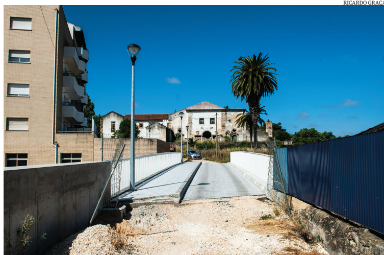
Trabalhos têm um prazo de execução de 90 dias
