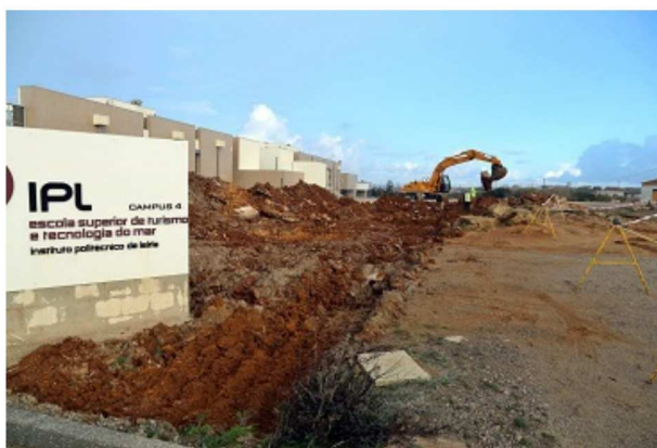
Aspetto das obras de requalificação
