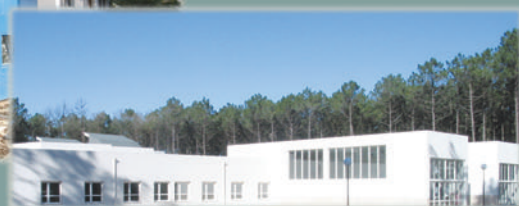
Edifício F da ESTGAD
